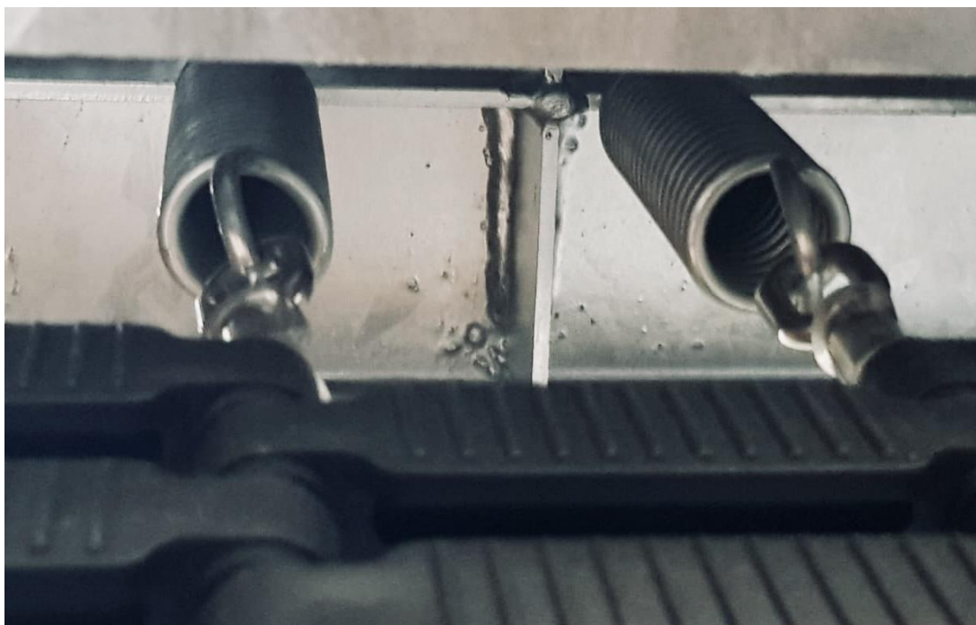
Einbausituation Federn/Matte auf der Sprungmatten-Seite mit Ösen
